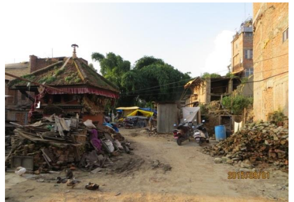
(カトマンズ市内の倒壊した古い寺院)
